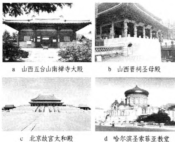
图 1 我国古代木结构建筑示例
